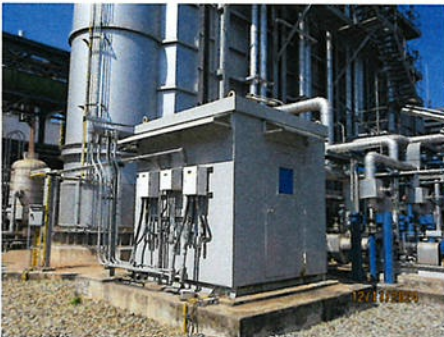
ภาพที่ 2-3 ระบบตรวจสอบคุณภาพอากาศแบบต่อเนื่อง (CEMS) ของโรงไฟฟ้า
