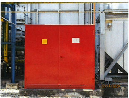
ภาพที่ 2-63 ระบบป้องกันเพลิงไหม้ โดยใช้ก๊าซ คาร์บอนไดออกไซด์ บริเวณเครื่องกังหันก๊าซ
