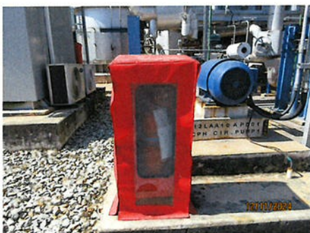
ภาพที่ 2-55 ถังดับเพลิงมือถือชนิดสารเคมีแห้ง
