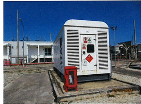
ภาพที่ 2-43 ระบบไฟฟ้าส่องสว่างฉุกเฉินภายในอาคาร และระบบสำรองไฟฉุกเฉินของทั้งโรงไฟฟ้า
