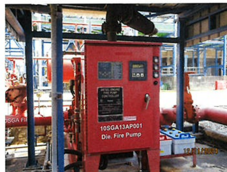
ภาพที่ 2-58 Diesel Engine Driver Fire Water Pump
