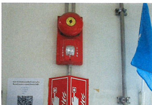
ภาพที่ 2-51 ระบบเตือนภัย (Fire alarm)
