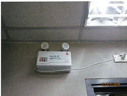
ภาพที่ 2-43 ระบบไฟฟ้าส่องสว่างฉุกเฉินภายในอาคาร และระบบสำรองไฟฉุกเฉินของทั้งโรงไฟฟ้า
