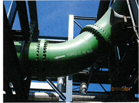
ภาพที่ 2-40 เครื่องหมายทิศทางไหลของระบบท่อ
