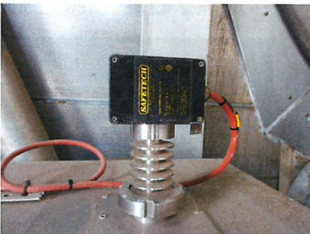
ภาพที่ 2-49 อุปกรณ์ตรวจสอบความรั่วไหลของก๊าซ (Gas Detector)
