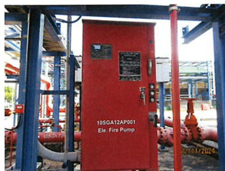
ภาพที่ 2-54 Electric Motor Driven Fire Water Pump
