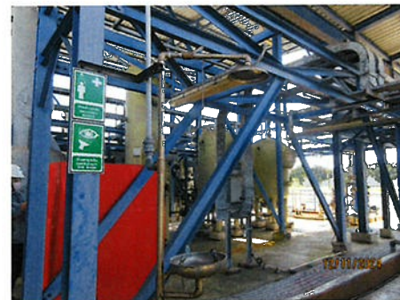
ภาพที่ 2-32 Emergency Eye Shower and Washer
