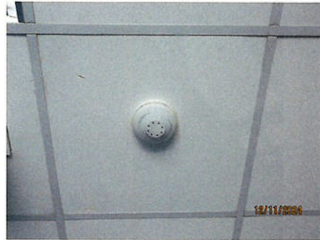
ภาพที่ 2-46 ระบบตรวจจับความร้อน (Heat Detector)
