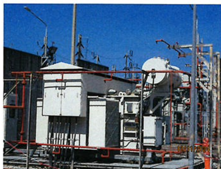
ภาพที่ 2-60 Automatic Water Spray System
