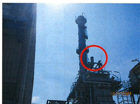
ภาพที่ 2-6 การติดตั้ง Silencer บริเวณปลายท่อที่อาจก่อให้เกิดเสียงดัง
