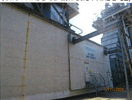
ภาพที่ 2-7 การปิดคลุม (Enclosures) ที่แหล่งกำเนิดเสียง
