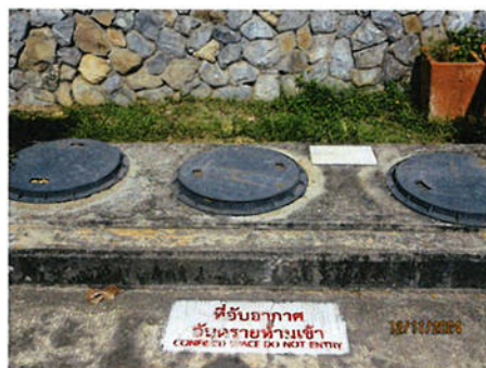
ภาพที่ 2-13 ระบบถังเกรอะ
